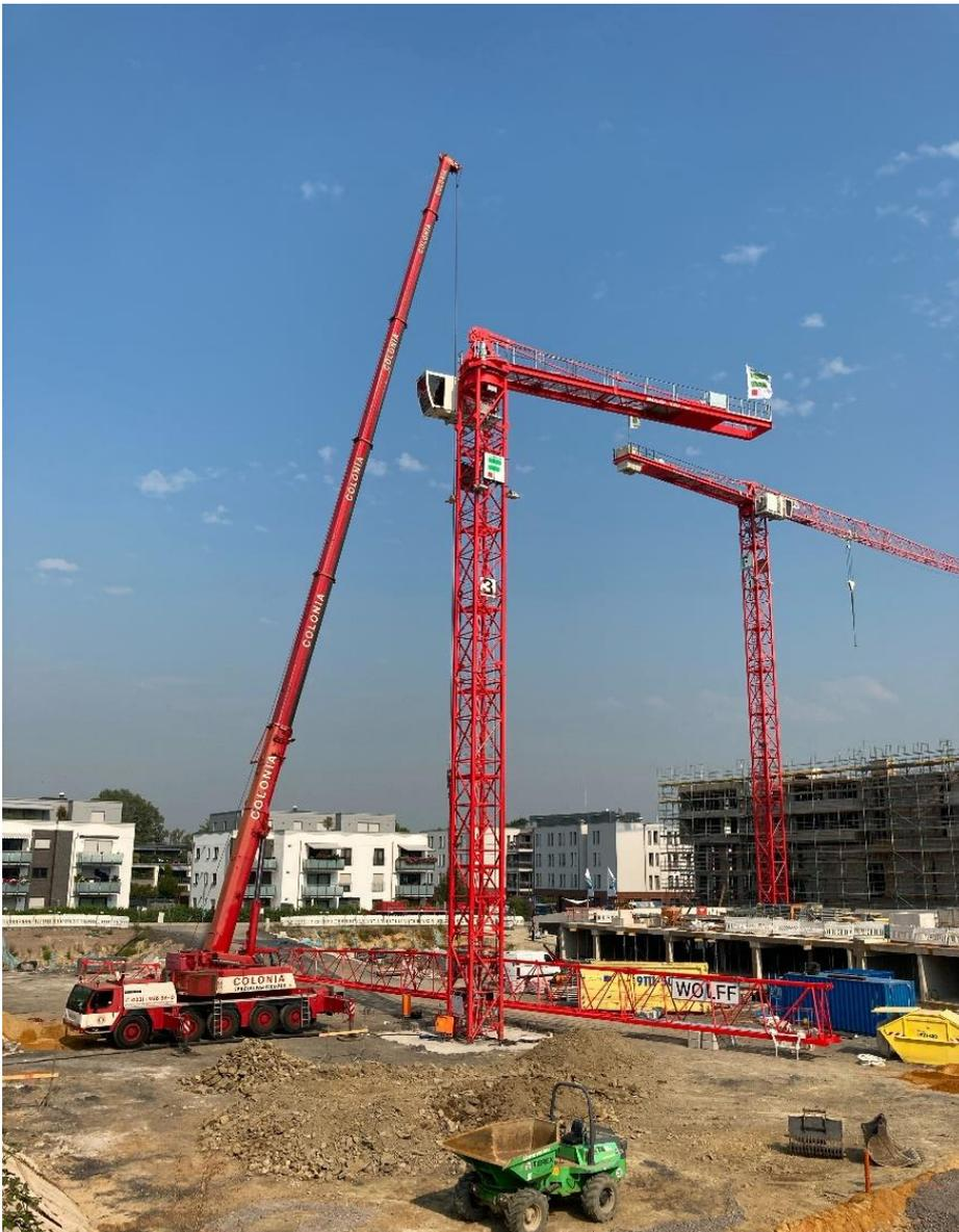
Montage und Demontage wurden vorab detailliert geplant. Das Foto zeigt die aufgeschüttete Rampe, über die Autokran und LKW die Baugruube befahren konnten.
