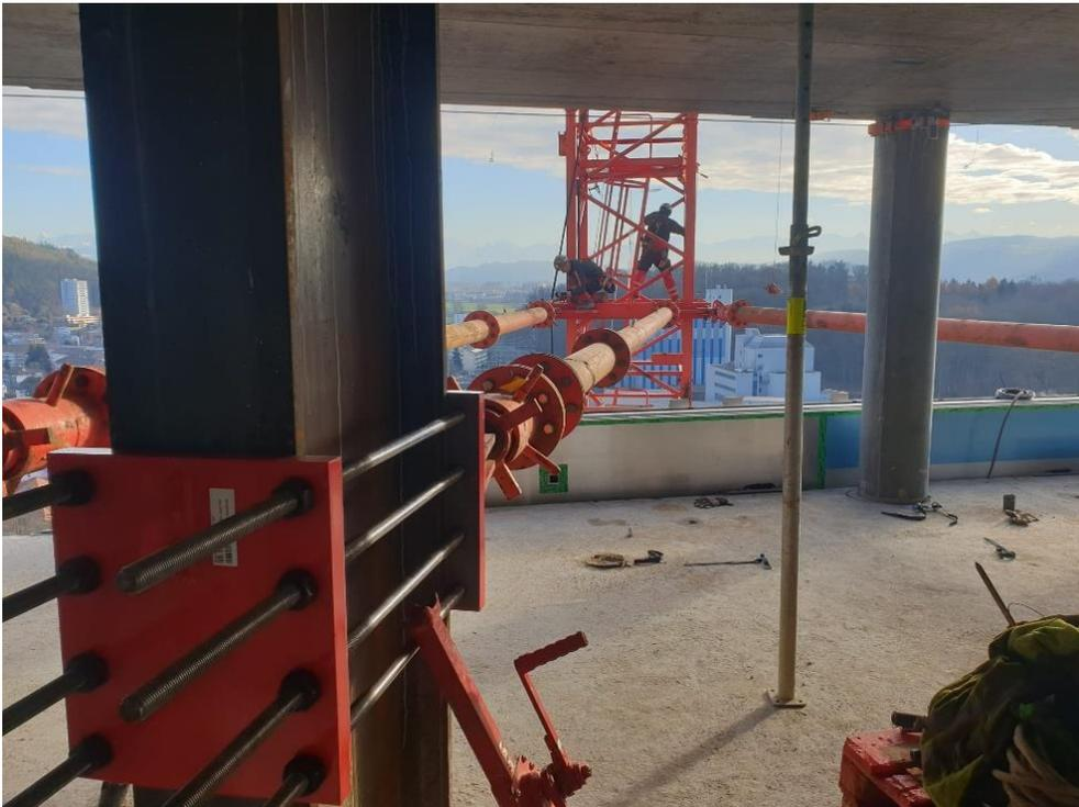
Die zwei Abspannungen, die den WOLFF 6031.8 Clear mit dem BäreTower verbinden, mussten weit im Inneren des Gebäudes fixiert und die Fassadenelemente außenherum gebaut werden.
