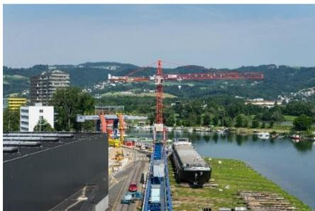
Der WOLFF 7532.16 *cross* unterstützt die Werft bei der Schiffswartung an Land. Auf Schienen montiert kann er flexibel agieren.
